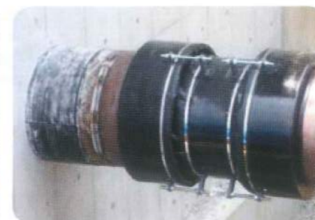
構造物取出後、可とう管として使用
