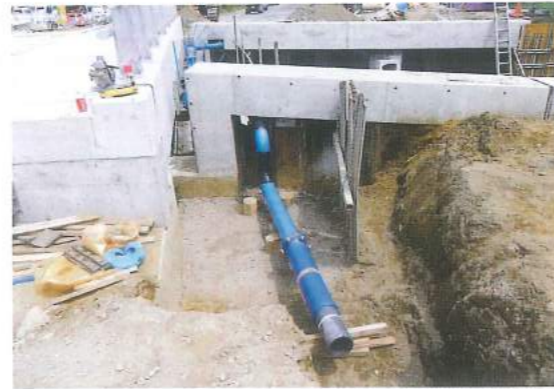
添架管の埋設部に可とう管として使用
