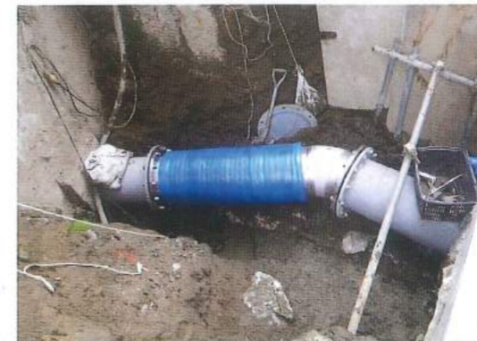
限られた空間で配置するために、 シナプスフレキと曲管を溶接により一体化
