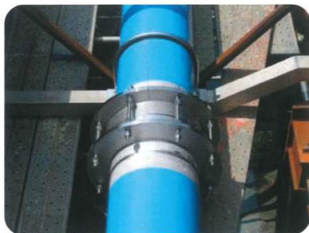
橋梁添架部での伸縮管として使用
