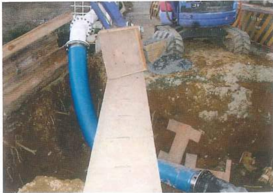
添架部から既設埋設管への接続管 (曲管+可とう管)として使用
