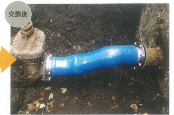
実際の配管形状に合わせた製品 さらなる沈下吸収も可能
