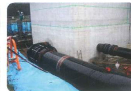
構造物取出後、曲げ配管にてタイロッド付可とう管として使用
