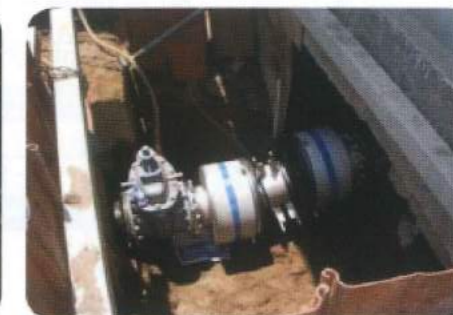
既存変位に合わせて可とう管を施工した例
