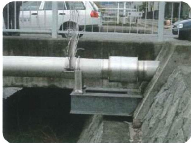
橋梁添架部での伸縮管として使用
