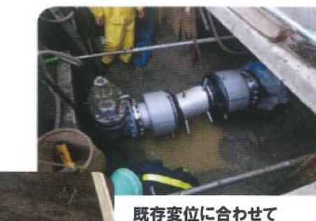
既存変位に合わせて可とう管を施工した例
