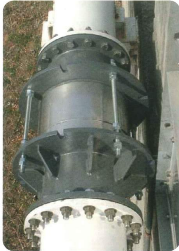
橋梁添架部での伸縮管として使用
