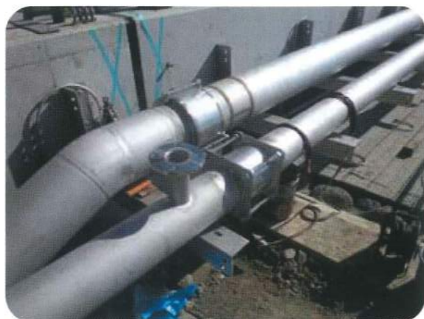
橋梁添架部での伸縮管として使用
