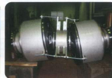
可とう管入れ替え時、既存の変位、角度、面間を計算して使用
