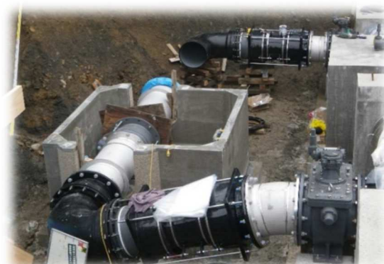
φ350 浄水場内埋設部にて使用【MTLW】
