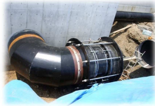
φ1500 浄水場内埋設部にて使用【MTLW】
