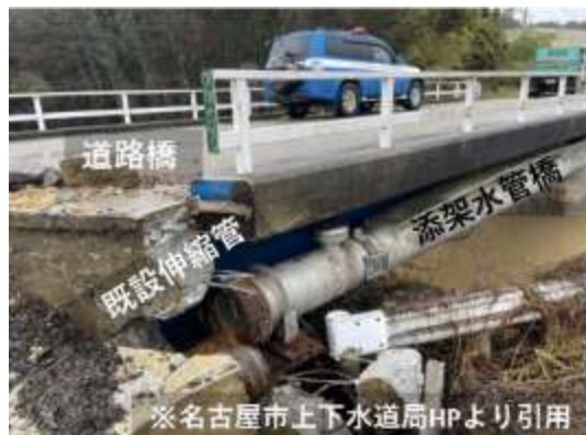
2024年能登半島地震での既設伸縮管の被害事例
