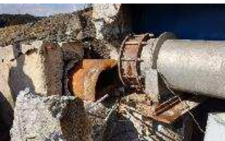
写真1 珠洲市水管橋の脱管被害
