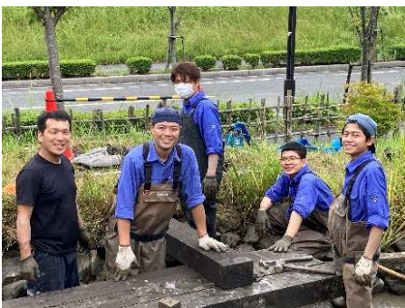
【作業中の様子】
